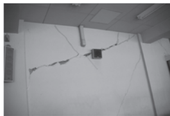
写真2 壁に生じたせん断ひび割れ
