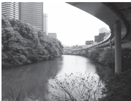
喰違門より弁慶堀を望む／首都高4号線の高架橋
