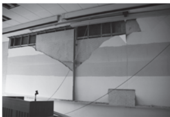
写真1 黒板が落下した教室
