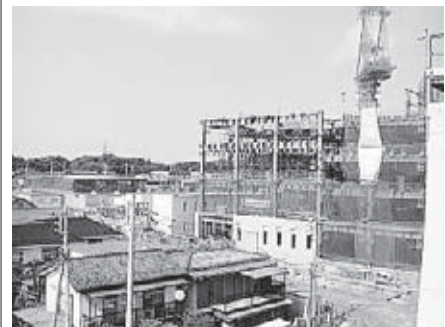
写真3 建設中の東館
