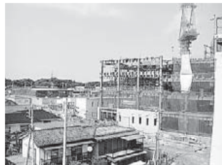
写真3 建設中の東館
